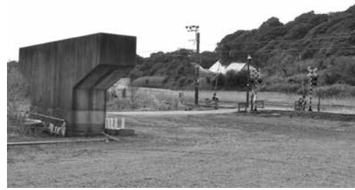
建設中の北ルート
