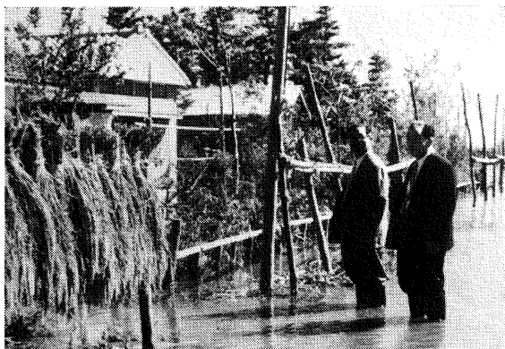
利根川氾濫（昭和33年9月28日）
