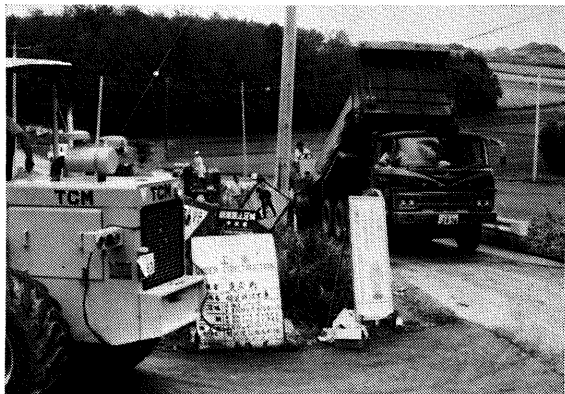
町道補修工事
