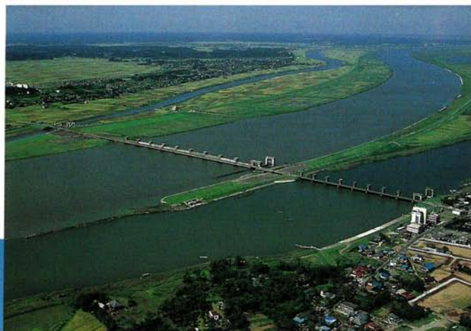
利根川河口堰
