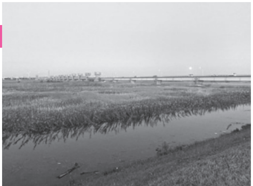
▲河川敷も水で溢れる
