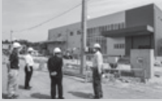
▲建設中の給食センターを視察
