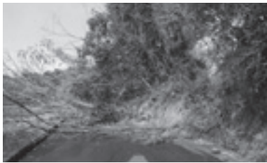
▲町内でのがけ崩れ (2011年)
