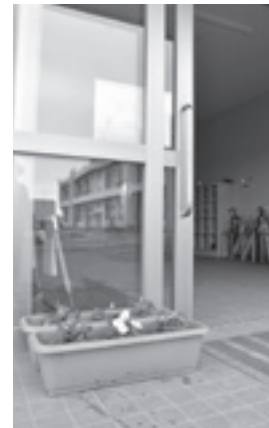
▲昇降口に設置
