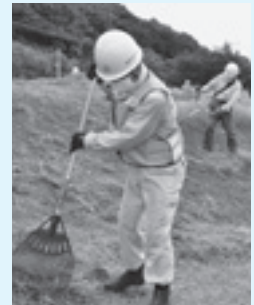
除草作業 (シルバー人材センター)
