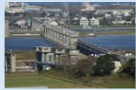
利根川河口堰
