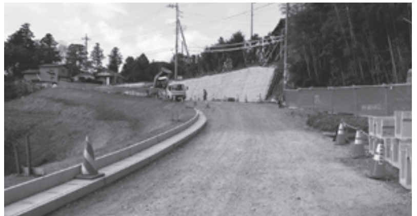
工事中の町道（窪野谷本郷地先）
