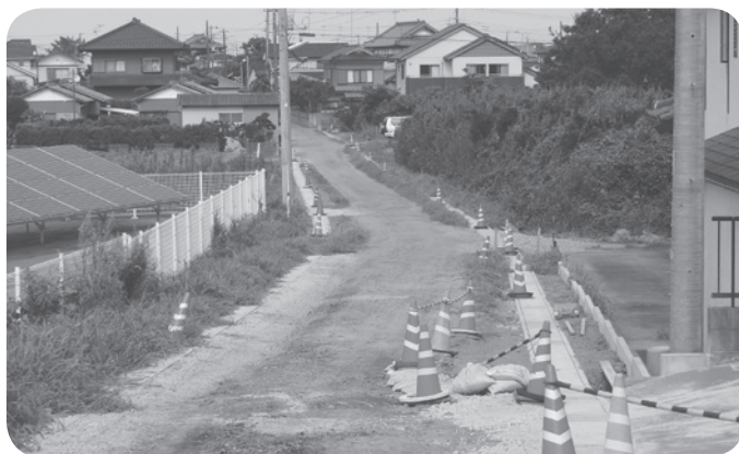
笹川駅南側道路工事
