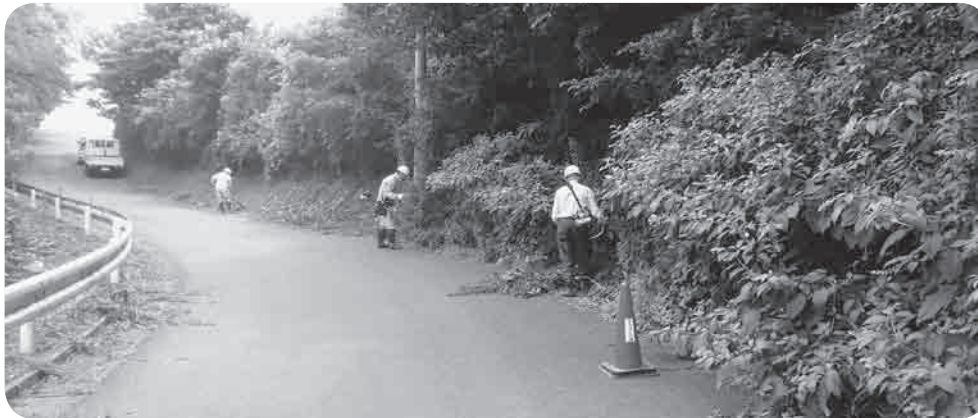
施設管理班による伐採
