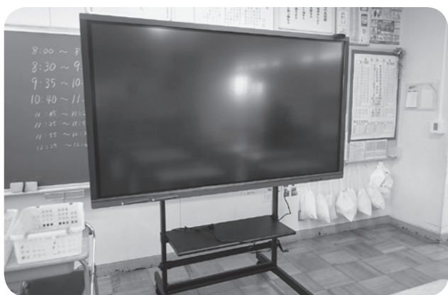
中学校に設置された電子黒板
