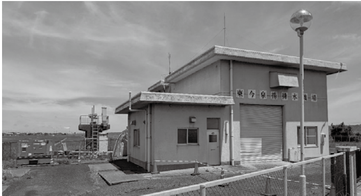
▲窃盗被害を受け電源が喪失した東今泉揚排水機場。 営農面・防災面の双方に影響が出ている。
