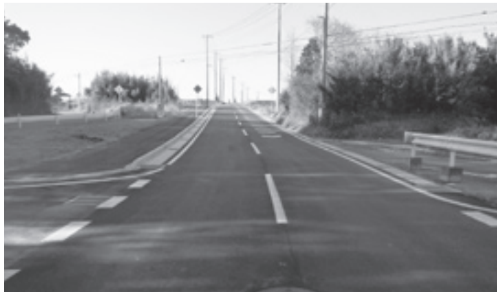
整備された町道 (小南地先)
