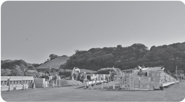
下総橋停車場東城線バイパス（通称：北ルート）新宿交差点付近
